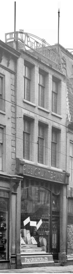
Gietijzeren belettering op het dak en vlaggenmasten # F Lange Viestraat 4 U 1935-DA
