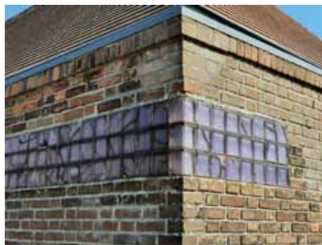
Gart Westerhout, voormalige toegangsgebouwen Academisch Ziekenhuis Leiden, plm. 1925. Rijnsburgerweg 8 en 12, Leiden (boven) en detailfoto (onder).
