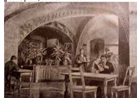
Afb. 3. Restauratie van het Rijksmuseum, uit: F.D.O. Obreen, Guide to the National Museum at Amsterdam, with illustrations by Wilm Steelink and ground plans, Schiedam 1887.
